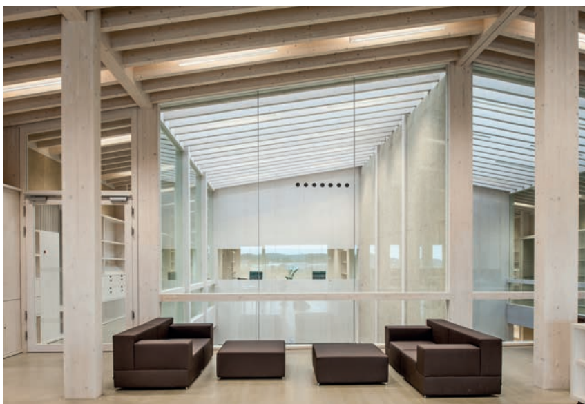
Neubau eines Schulgebäudes in Holzskelettbauweise. Das Schmuttertal Gymnasium in Diedorf (Bayern) wurde in Holzbauweise errichtet; Innenaufnahme Sitzbereich.
